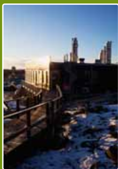
Bilden visar Henriksdals anläggning för gasbehandling i Stockholm. I anslutning ligger Henriksdalsverket som är ett av Sveriges största avloppsreningsverk.
